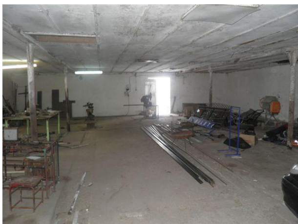
3. Widok wnętrza obiektu przeznaczonego na stację demontażu pojazdów.
