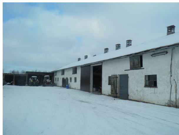
2. Widok budynku przeznaczonego na stację demontażu pojazdów.
